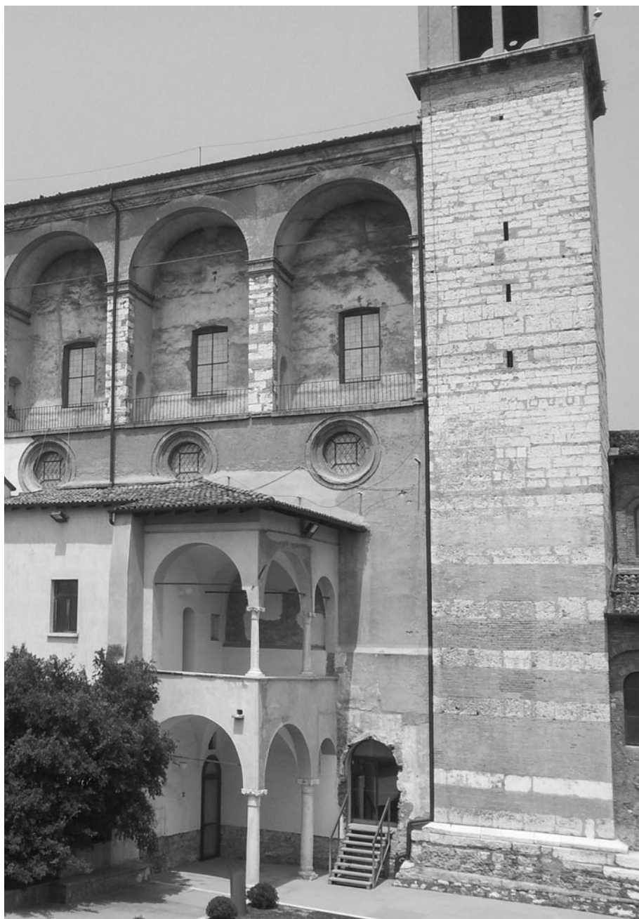
Fig. 18. Brescia, basilica di San Salvatore, campanile, parete sud.
